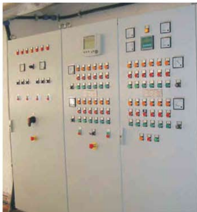
Fig. 1. Tablou de comandă și automatizare a spălării filtrelor de apă.
