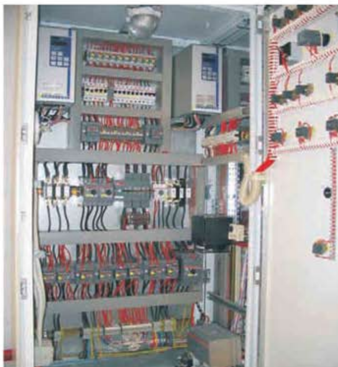
Fig. 1. Tablou de comandă și automatizare a spălării filtrelor de apă.
